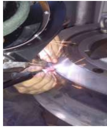
圖4. 鋼鐵廠 SKD-11 熱處理軋輥崩裂缺角冷焊修補，不能過熱、結合强度高、焊後硬度 HRC57~60°。
